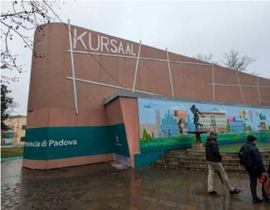
Fabbricato Kursaal - facciata est
