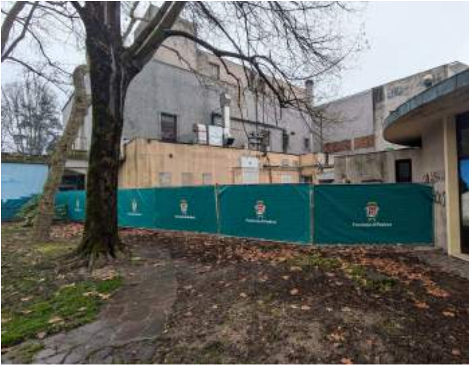
Fabbricato Kursaal - angolo nord-ovest
