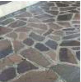
Blocchi di porfido con posa ad incerta
